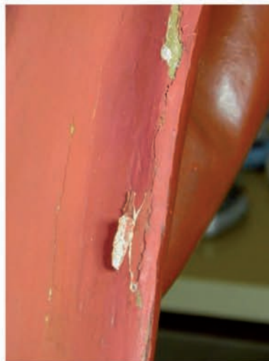
Parte del manto antes de empezar con la restauración.
